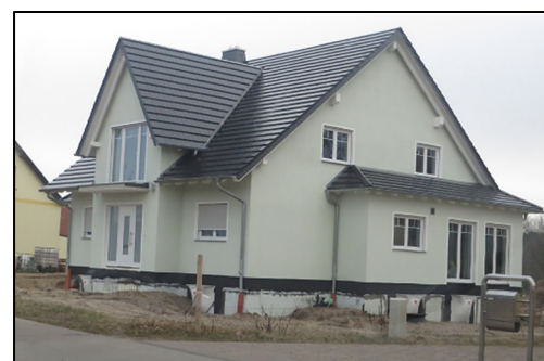
Foto-5: Neubau EFH in Mochau
