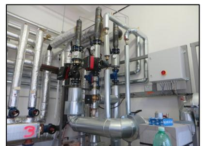
Foto-4: Gebäudeanschluss Nahwärme
