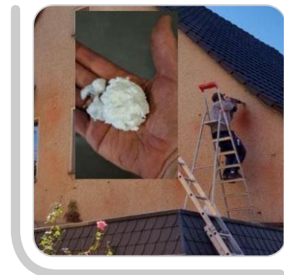
Einblasdämmung: Eintrag von außen
