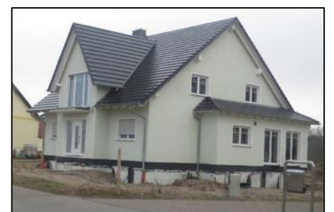
Foto-5: Neubau EFH in Mochau
