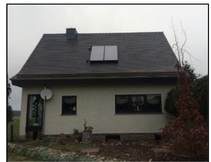
Foto-3: EFH (KfW-430), Holzdorf
